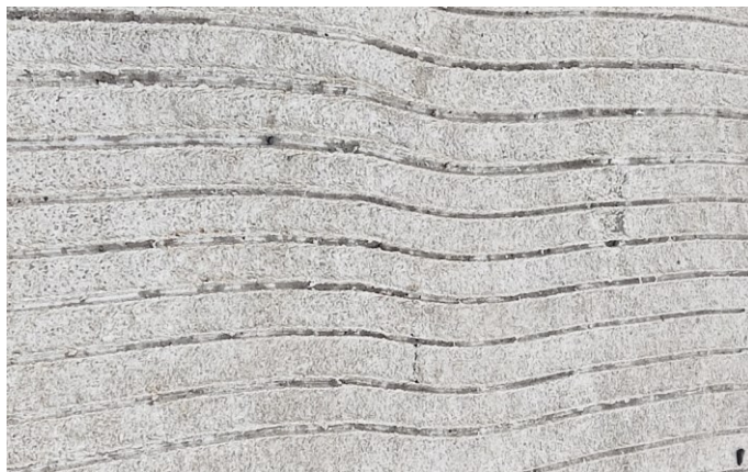
Obrázek 16 – Příklad zlepšení drsnosti a odvodňovacích vlastností velkoplošného VDZ
