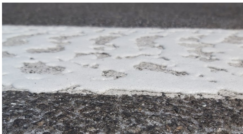
Obrázek 10 – NEDOSTATEČNÁ makrotextura značení
