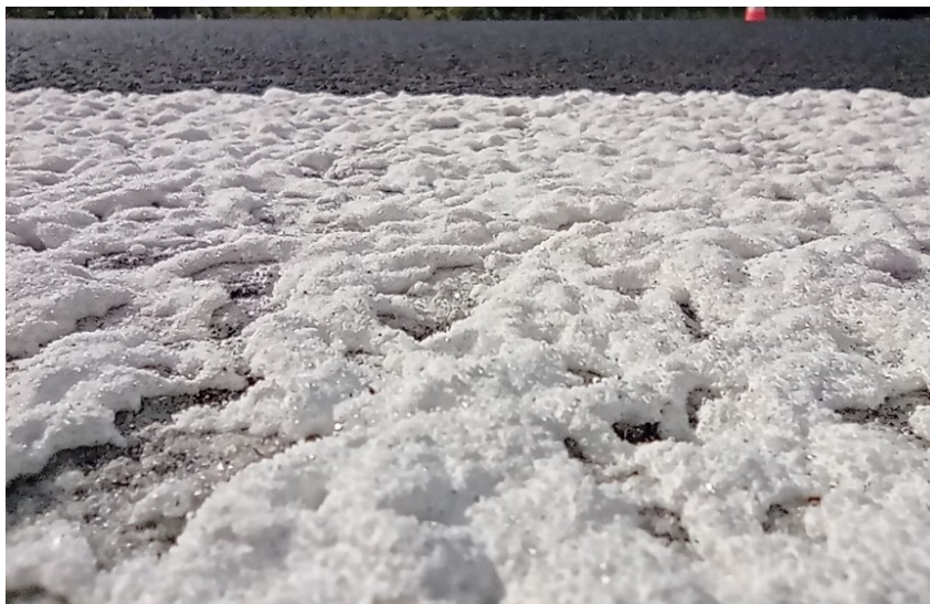
Obrázek 9 – Dostatečná makrotextura značení
