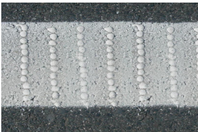
Obrázek 11 – Příklad VDZ typu II – profilované VDZ s podstříkem
