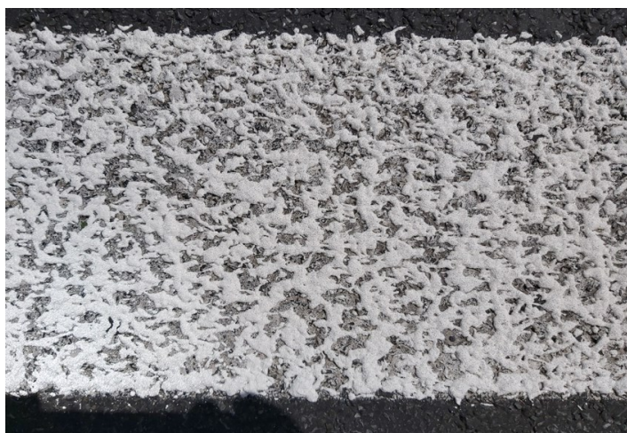
Obrázek 4 – Příklad VDZ typu II – strukturální VDZ
