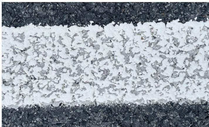
Obrázek 3 – Příklad VDZ typu II – strukturální VDZ
