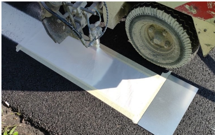
Obrázek 17 – Ukázka kontroly dávkování barvy a materiálu na dodatečný posyp
