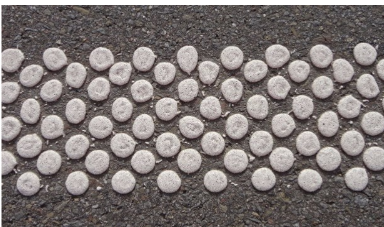
Obrázek 14 – Příklad VDZ typu II – profilované VDZ
