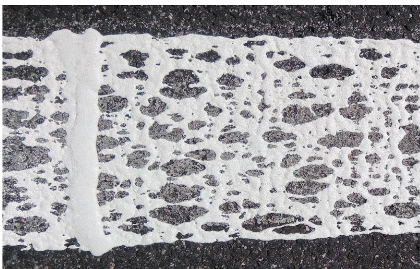
Obrázek 7 – NESPRÁVNÉ provedení strukturálního značení (nedostatečná makrotextura s uzavřenými mezerami)
