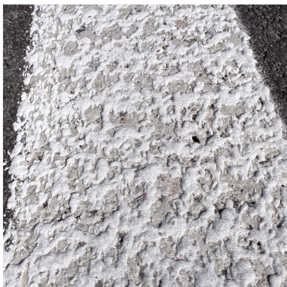
Obrázek 5 – Příklad VDZ typu II – strukturální VDZ
